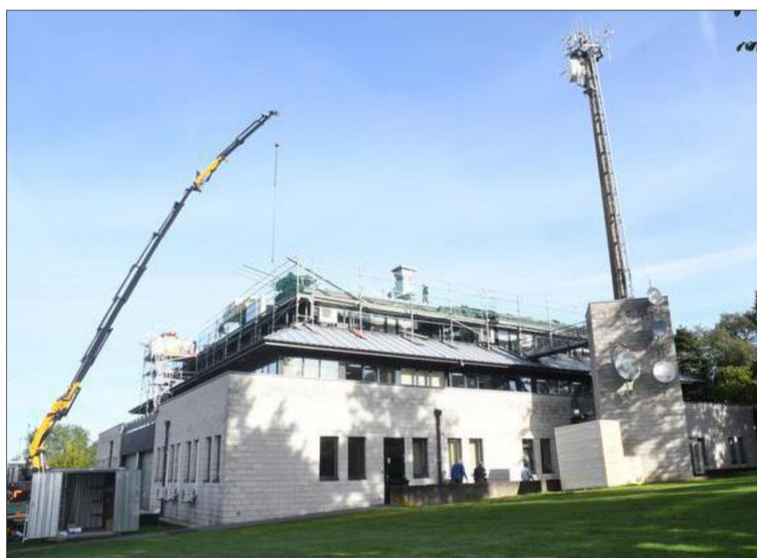
Die Arbeiten zur Neueindeckung des Daches am Funkhaus in Eupen liefen über rund sieben Wochen, größtenteils begünstigt durch die Witterung.
