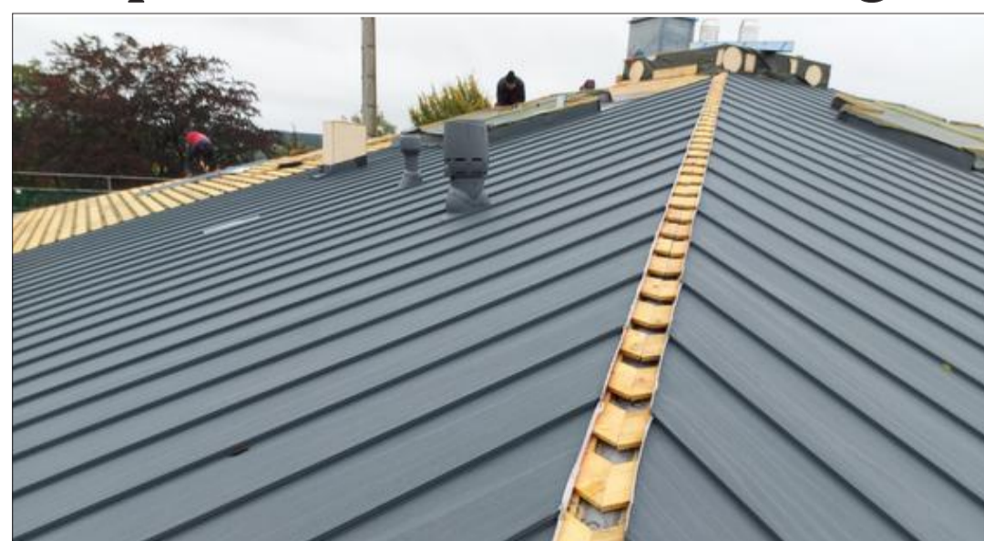
Die Finanzierung der neuen Bedachung am Funkhaus wurde durch eine Sonderkapitaldotierung in Höhe von 300.000 € seitens der Regierung „abgedeckt“
