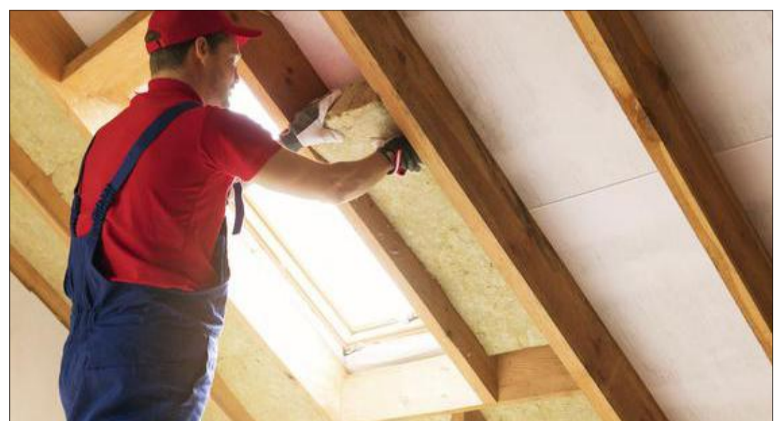
Meist starten die Sanierungsmaßnahmen zur Energieersparnis buchstäblich „unterm“ Dach, wo schon mit überschaubaren materiellen Mitteln eine hohe Dämmung erreicht werden kann.
