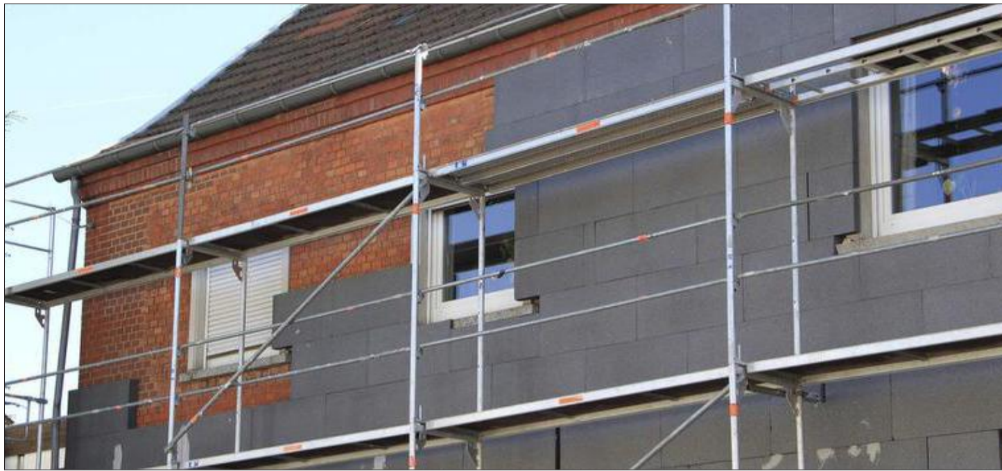
Eine Dämmung der Fassade ist in jedem Falle teuer. Weil eine solche Investition ein Gerüst erfordert, sollte sie möglichst nur in Zusammenhang mit einer Putzerneuerung oder einem Farbanstrich der Fassade aufgebracht werden. Fotos: Fotalia/nemo.presse
