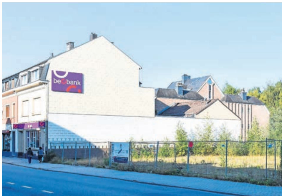
Mit den „Eupener Terrassen“ wird in der Aachener Straße eine unschöne Narbe geschlossen, die nach dem Aus der vormaligen Tankstelle seit acht Jahren brach liegt.
